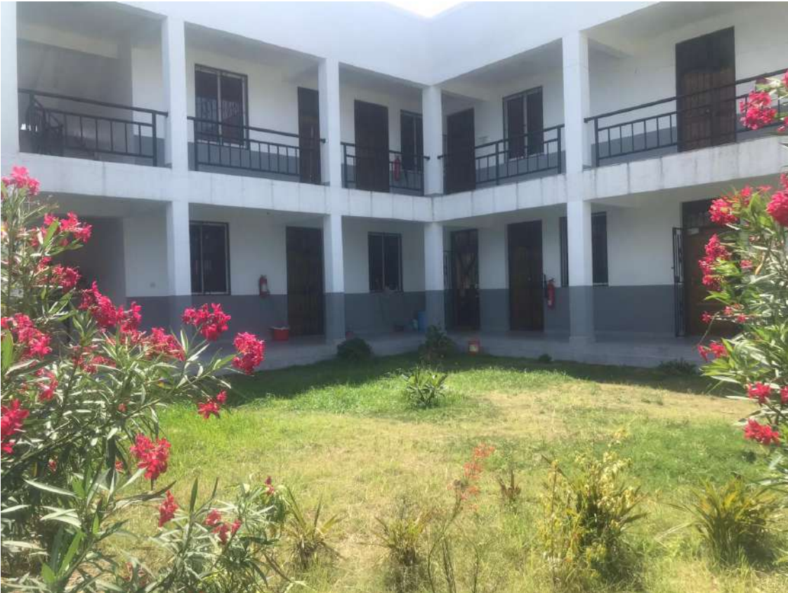
Edificio degli alloggi
